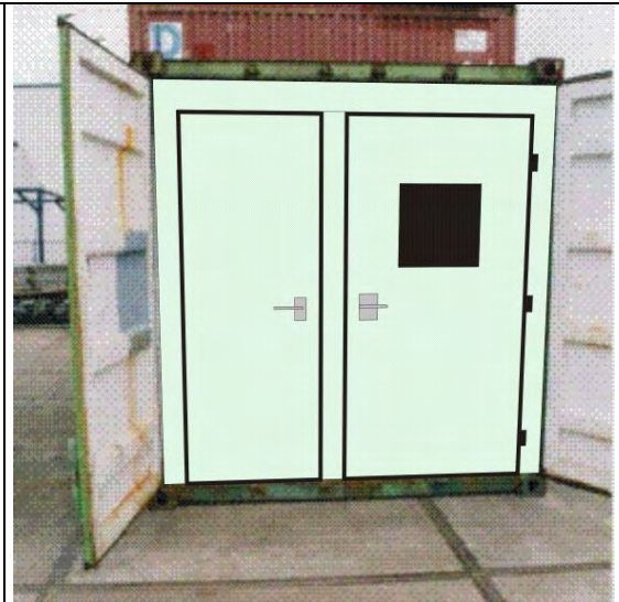
De tot cel verbouwde container. Links de deur naar de technische ruimte en rechts de deur naar het bewonerscompartiment.
