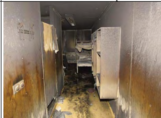
Een uitgebrand bewonerscompartiment na afloop van de Schipholbrand
